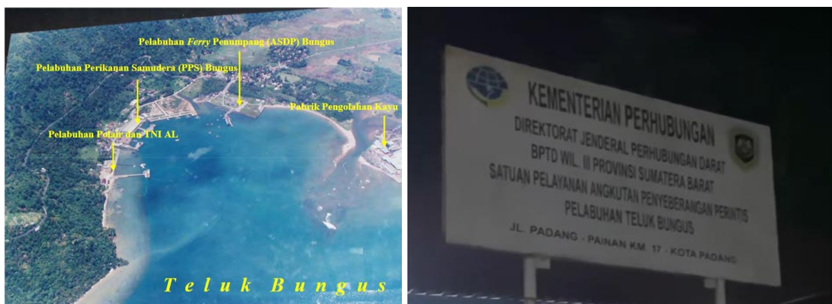
Gambar 1. Pelabuhan Teluk Bungus
