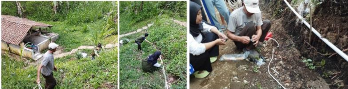
Gambar 11. Proses instalasi kelistrikan oleh mahasiswa
