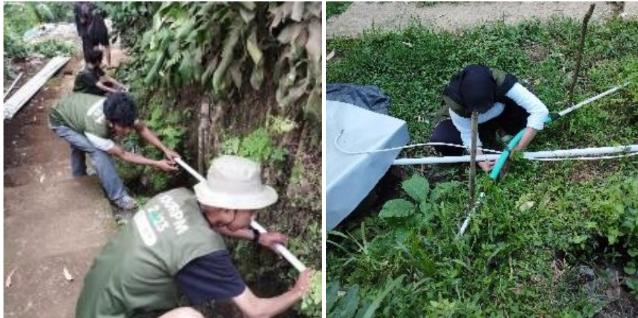
Gambar 13. Pemasangan jalur perpipaan dan penambalan pipa bocor
