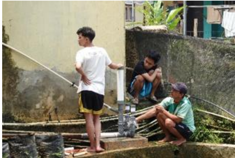
Gambar 8. Uji Coba Pompa dan pemasangan pipa distribusi
