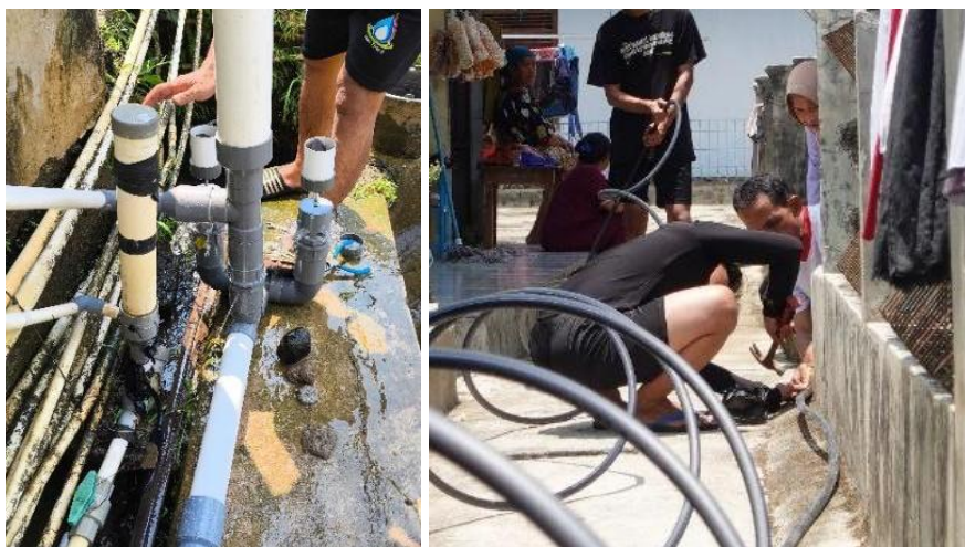
Gambar 7. Uji Coba Pompa dan pemasangan pipa distribusi
