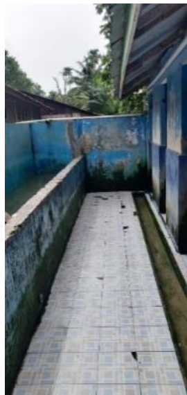
Gambar 3. Memasang Aliran pipa dalam tiap Bak
