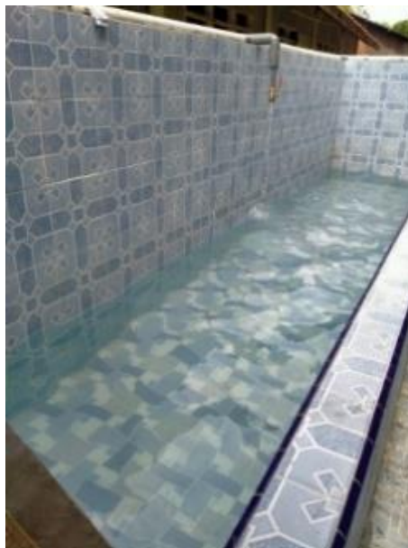
Gambar 9. Melakukan pemasangan nat agar tiap keramik terkunci
