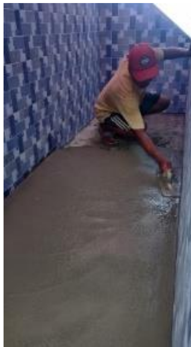
Gambar 7. Melakukan pekerjaan lantai bak diawali dengan kacoan Semen
