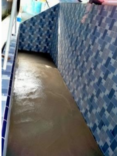
Gambar 8. Tunggu agar lantai kerja mengering
