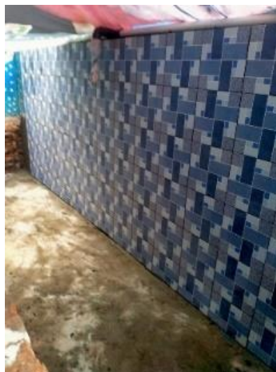
Gambar 5. Melakukan pemasangan keramik dinding
