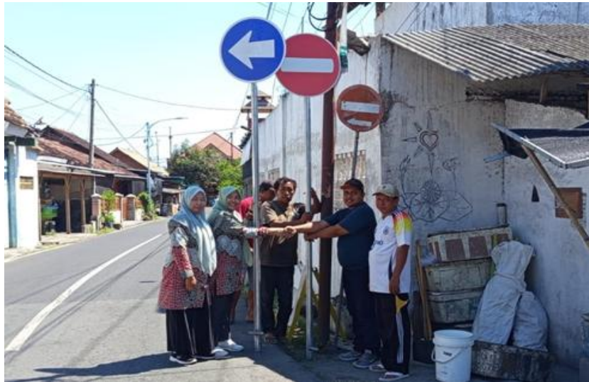
Gambar 5. Pemasangan Rambu Lalu Lintas
