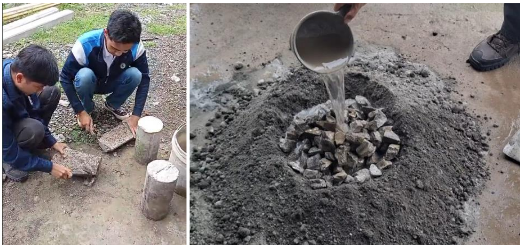
Gambar 4. Pembuatan Campuran Beton
