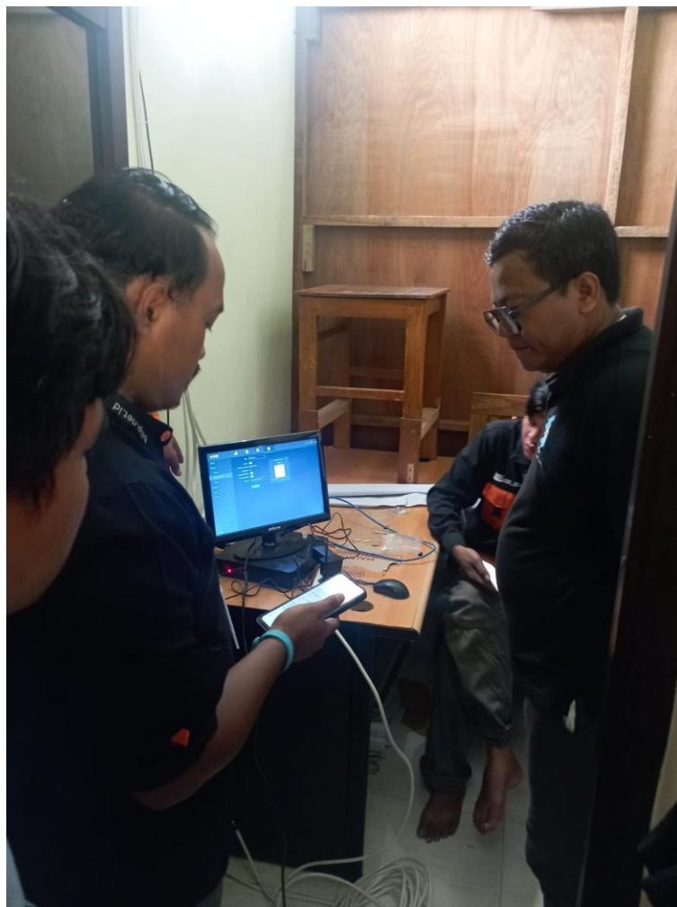
Gambar 2. Instalasi perangkat jaringan tambahan
