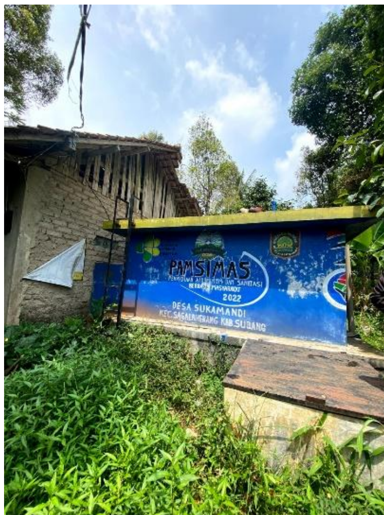
Gambar 2. Kondisi awal area bak penampungan air
