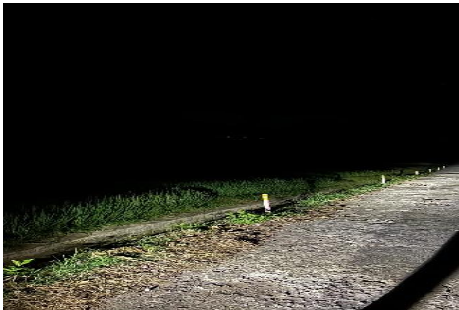
Gambar 4. Pemasangan reflektor di lokasi
