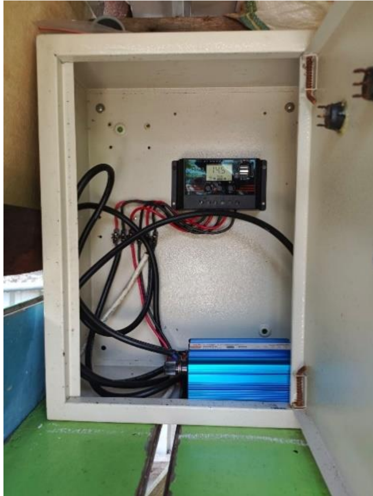
Gambar 7. Controller dan inverter
