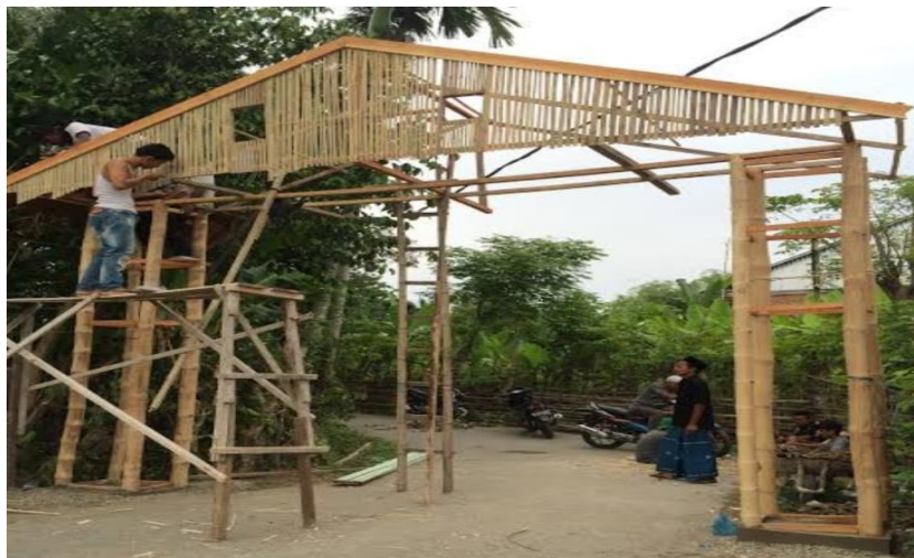
Gambar 4. Pembuatan pintu gerbang berbahan bambu Dusun Pepao lokasi desa wisata cerdas
