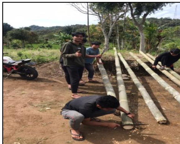
Gambar 4. Permbersihan Permukaan Bambu
