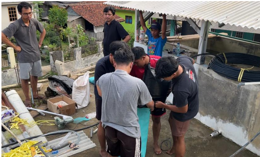
Gambar 6. Pengerjaan water treatment dengan penambahan media filtrasi
