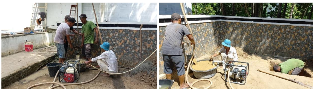
Gambar 7. Pengeboran dengan kedalaman 6-15 meter dengan menggunakan mesin dup pompa kecil
