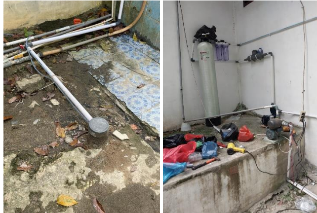
Gambar 9. Pemasangan filtrasi
