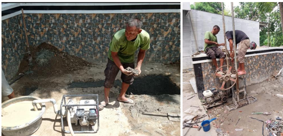
Gambar 8. Pengeboran dengan kedalaman 60 meter dengan menggunakan mesin dup pompa besar dengan alat ungkit-ungkit
