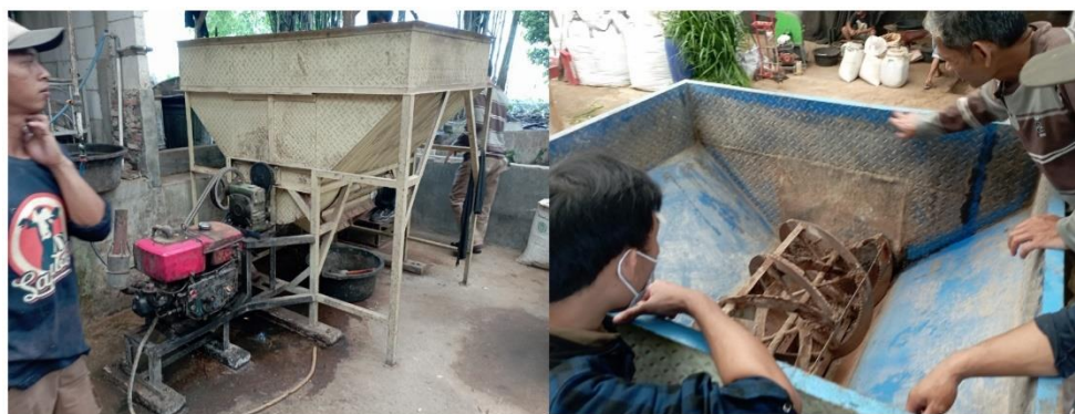
Gambar 2. Mesin pengaduk existing milik SapiBos Farm
