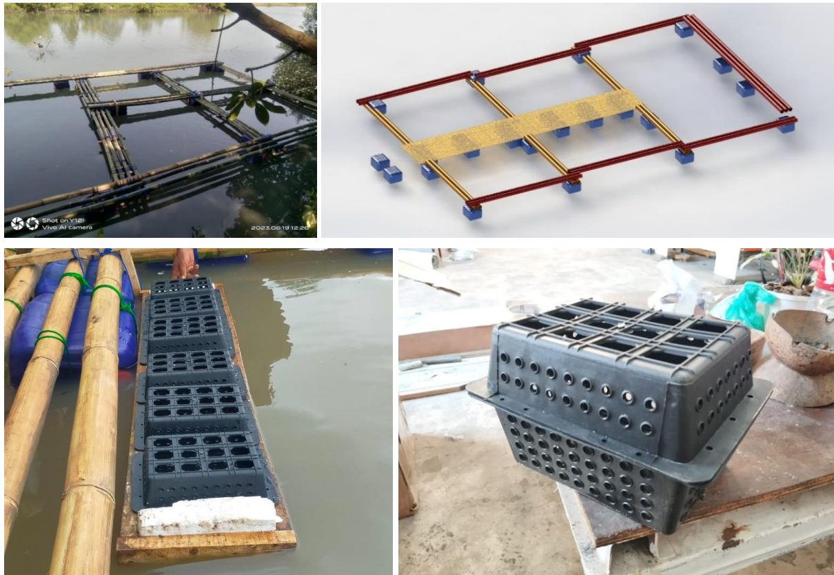
Gambar 6. Hasil Pembuatan Dermaga Apung Dengan dilengkapi Crab Box
